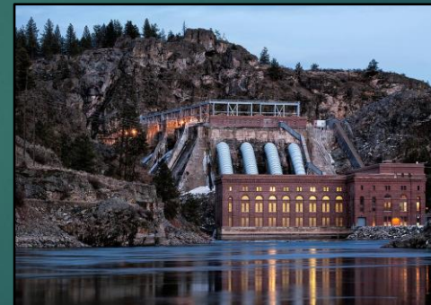
Long Lake Dam, Avista Corp
